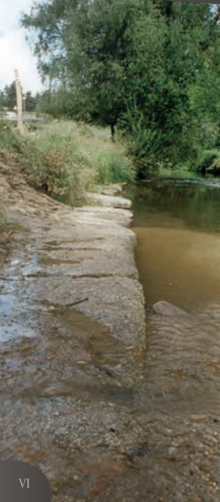
Aménagement de la berge gauche
