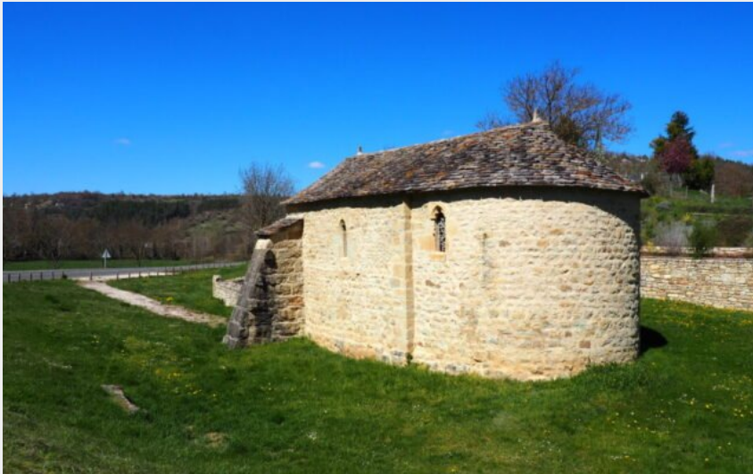
Le patrimoine bâti du Gévaudan (Office de Tourisme Gévaudan Destination)
