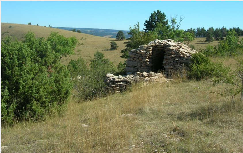
Chazelle sur la montagne fendue (OTCCGD)
