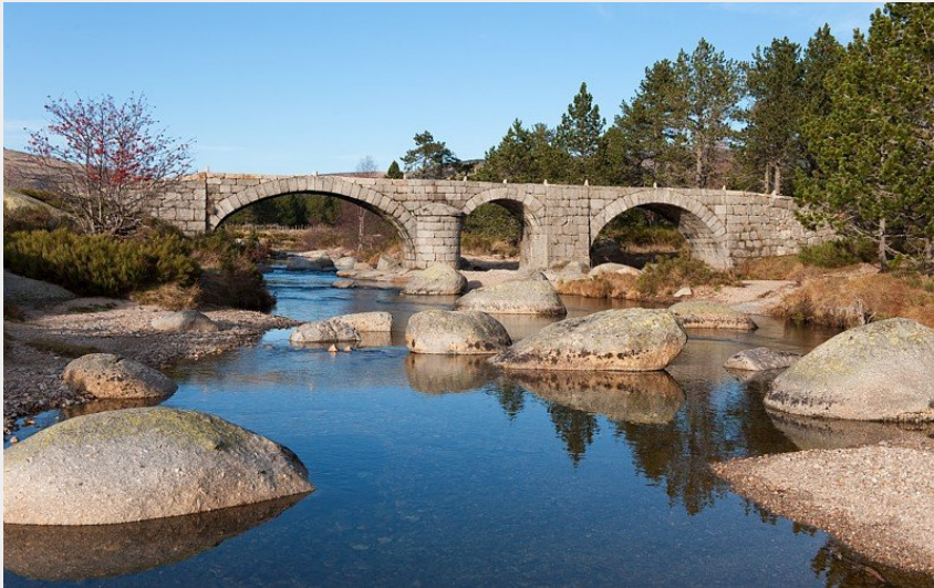
Le pont du Tarn (© Guy Grégoire)
