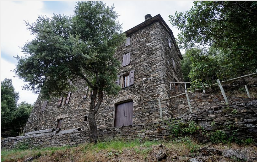
Magnanerie de La Roque (© A. Bouissou/TERRA)
