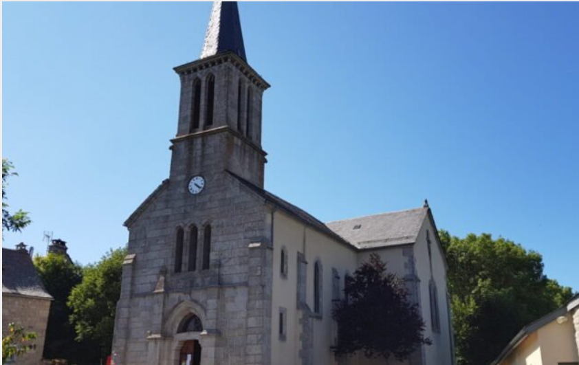
L'église de Saint-Laurent-de-Muret (OTCC Gévaudan Destination)
